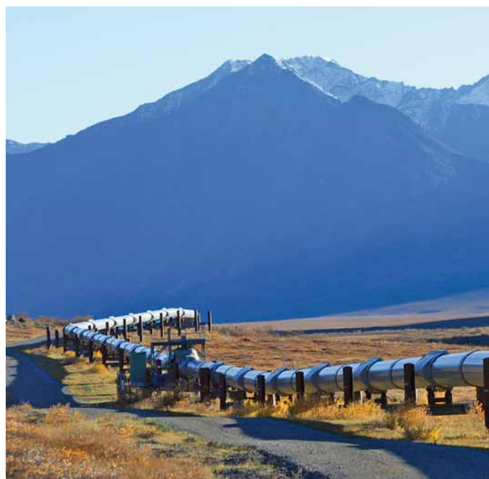
Fernwärmelieferung: Preisänderungsklauseln müssen auch ein Kostenelement enthalten
