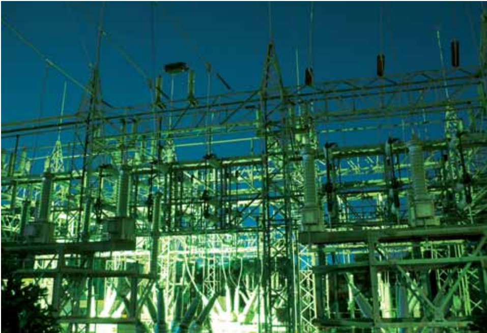
PV-Anlagen müssen zur Vorbeugung gegen ein Blackout nachgerüstet werden
